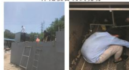
一体化设备调试现场
