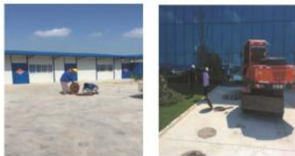
阜宁项目部现场
